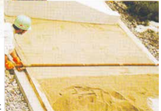
敷きモルタルの施工
